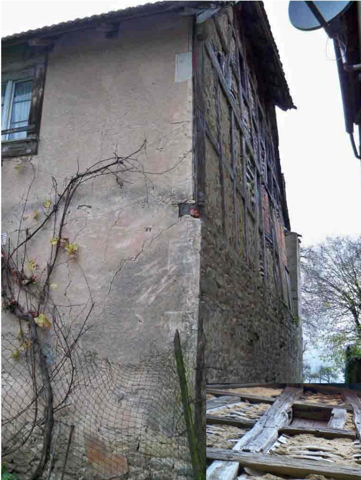
Le pignon droit est visiblement contemporain de la façade avant, construit, comme elle, de pierre au rez-de-chaussée et de pan de bois à l'étage. Des bois qu'il serait intéressant de dater par dendrochronologie, du moins si l'on peut trouver des traces d'aubier sur l'une ou plusieurs de ces poutres. La dendrochronologie ne permet toutefois que de dater l'année d'abattage du bois et non celle de sa mise en œuvre.
