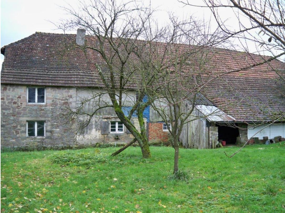
On observe, sur le versant arrière de la toiture, la présence de tuiles écailles dites « queue de castor ». la façade arrière est moins facilement lisible que la façade avant, mais on observe, sur la partie centrale, le double usage apparent, du moins à l'origine, de la pierre et du pan de bois.
