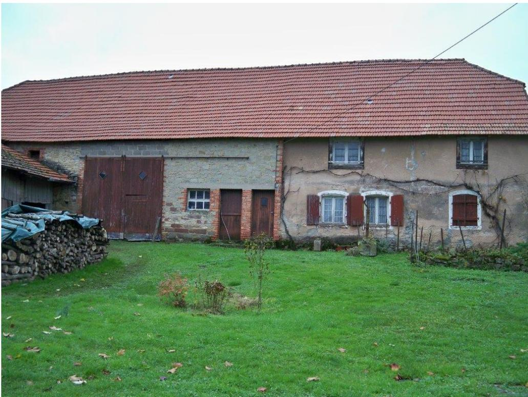
Par le style de ses ouvertures – linteaux en segments d'arc délardés -, le logis est datable de la seconde moitié du XVIII<sup>e</sup> siècle. Le rez-de-chaussée est construit de pierre, l'étage en pan de bois ; il est probable que les deux structures soient contemporaines, la maison ayant été bâtie de manière hybride.
