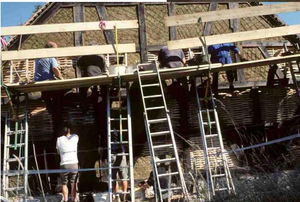
Une partie de l'équipe a travaillé à l'extérieur, sur des échafaudages agrafés à des échelles, un procédé parfaitement dans les normes.
