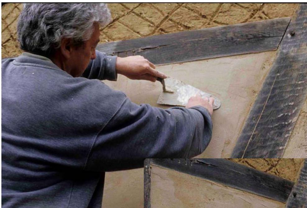
La surface de l'enduit doit venir au « nu » du pan de bois, pour former un plan uniforme, de manière à ce que les pluies n'accrochent pas.
