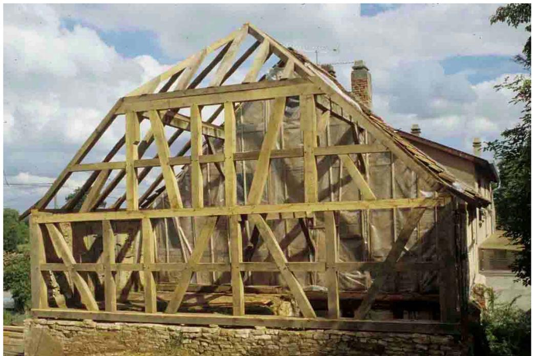
2003, le support, destiné à recevoir le torchis, a été conçu dans la tradition, à partir d'étrésillons et de clayonnages, étrésillons façonnés avec du bois de palette.
