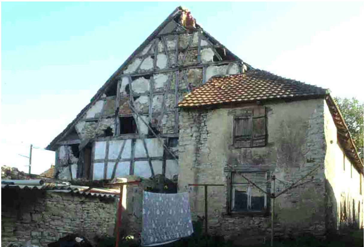
Extension, reprise en pierre à l'arrière
