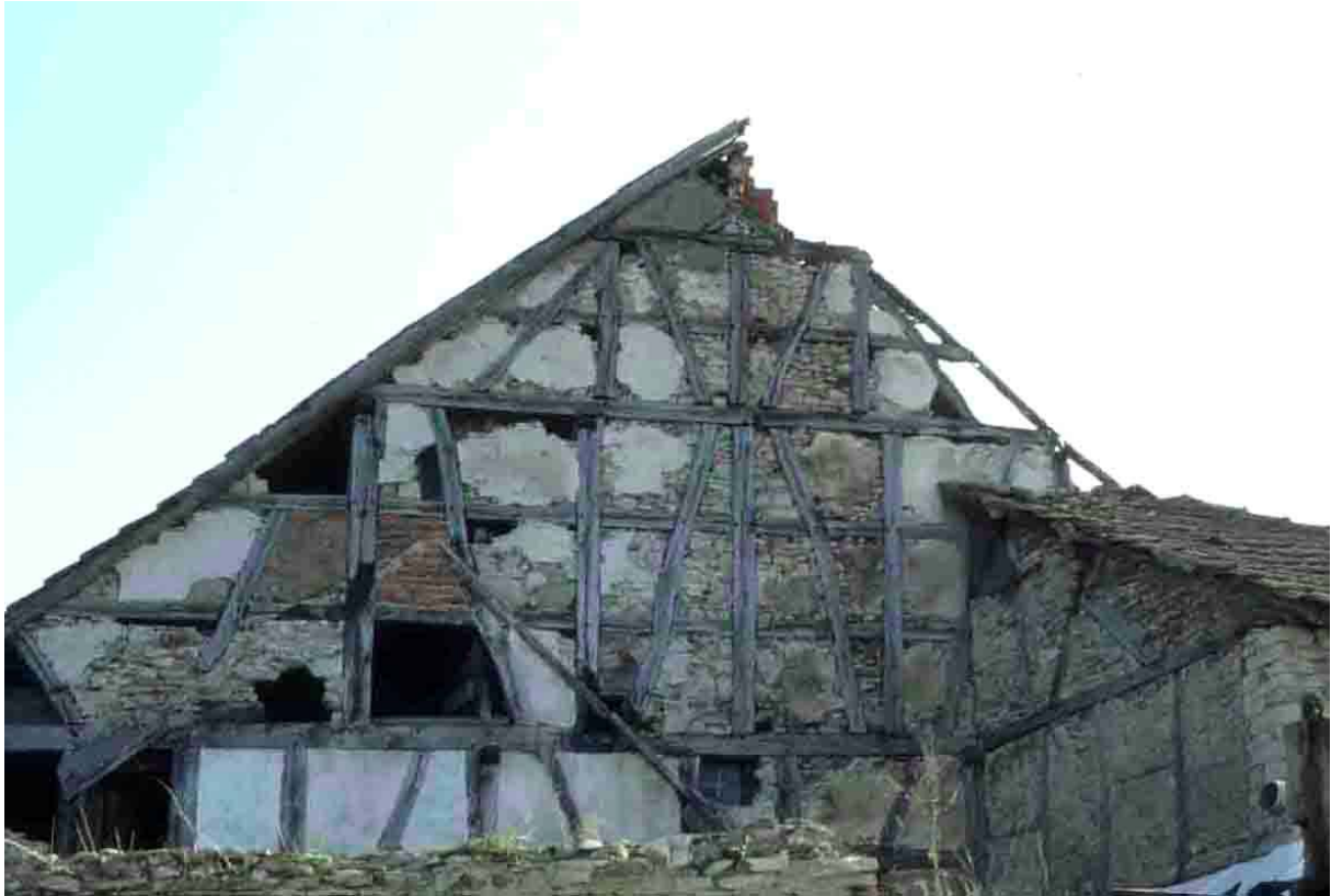
Pignon classique à deux entretroises en partie basse.
