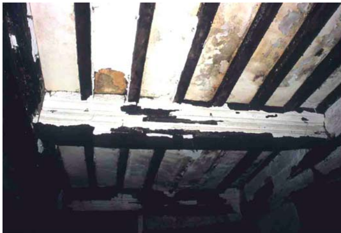
Plafond à la française, sous dalle d'oestrich.
