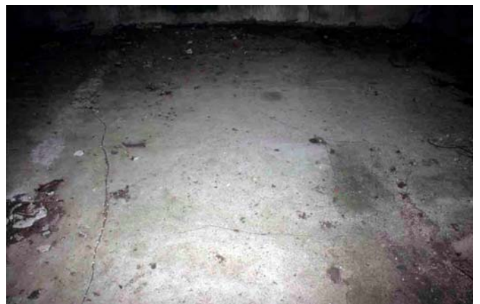
Dalle d'oestrich en sol d'étage.
