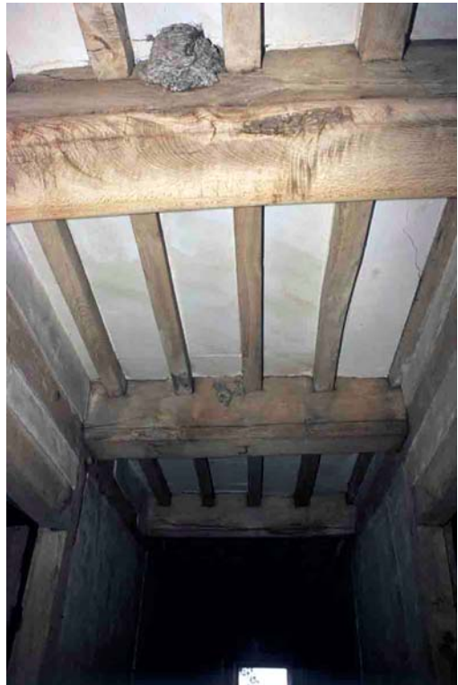
Plafond à la française avec entrevous en oestrich.
