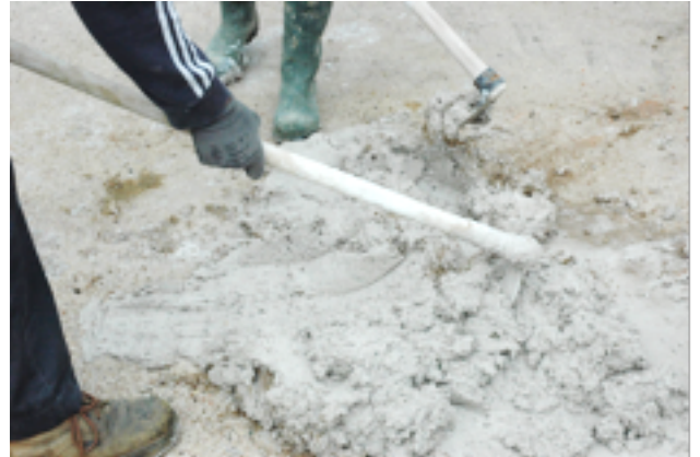
Extinction avec l'eau de gâchage : la chaux vive est éteinte avec la réalisation du mortier
