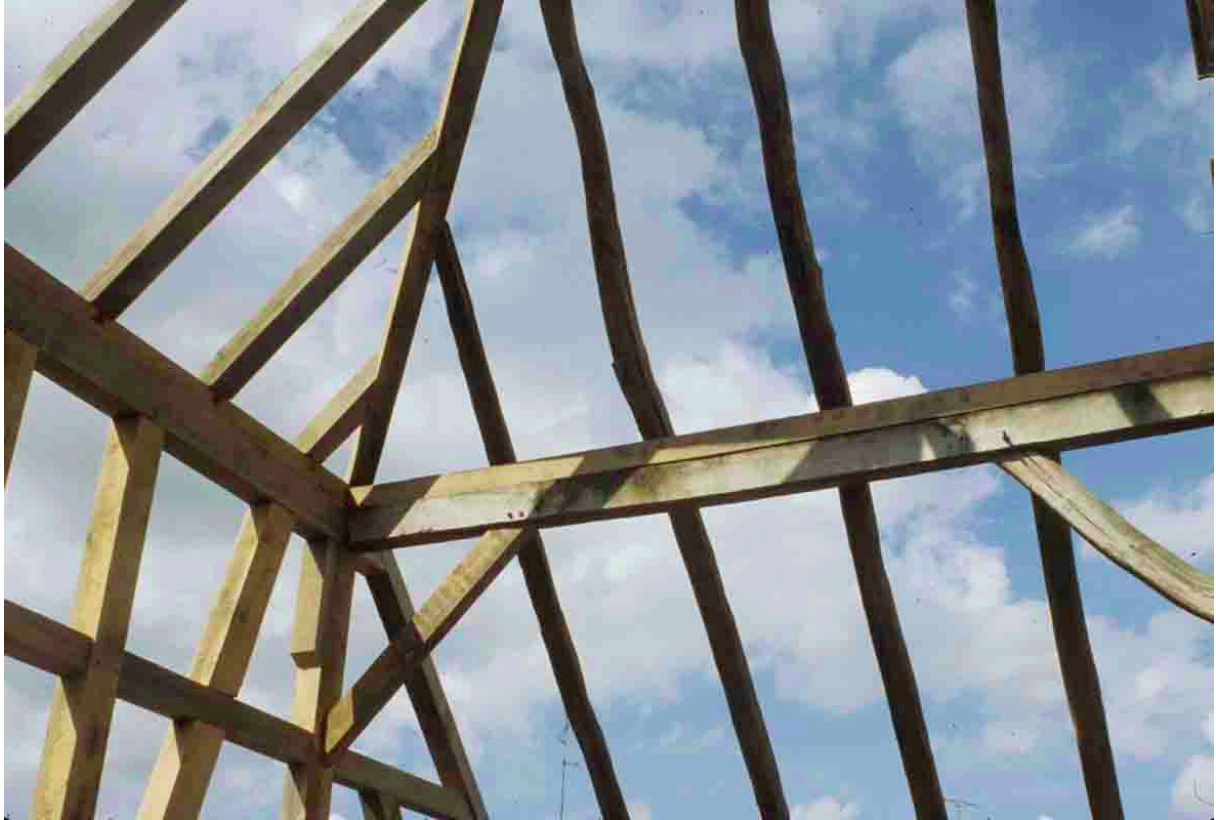
La réfection de la charpente, en 1995
