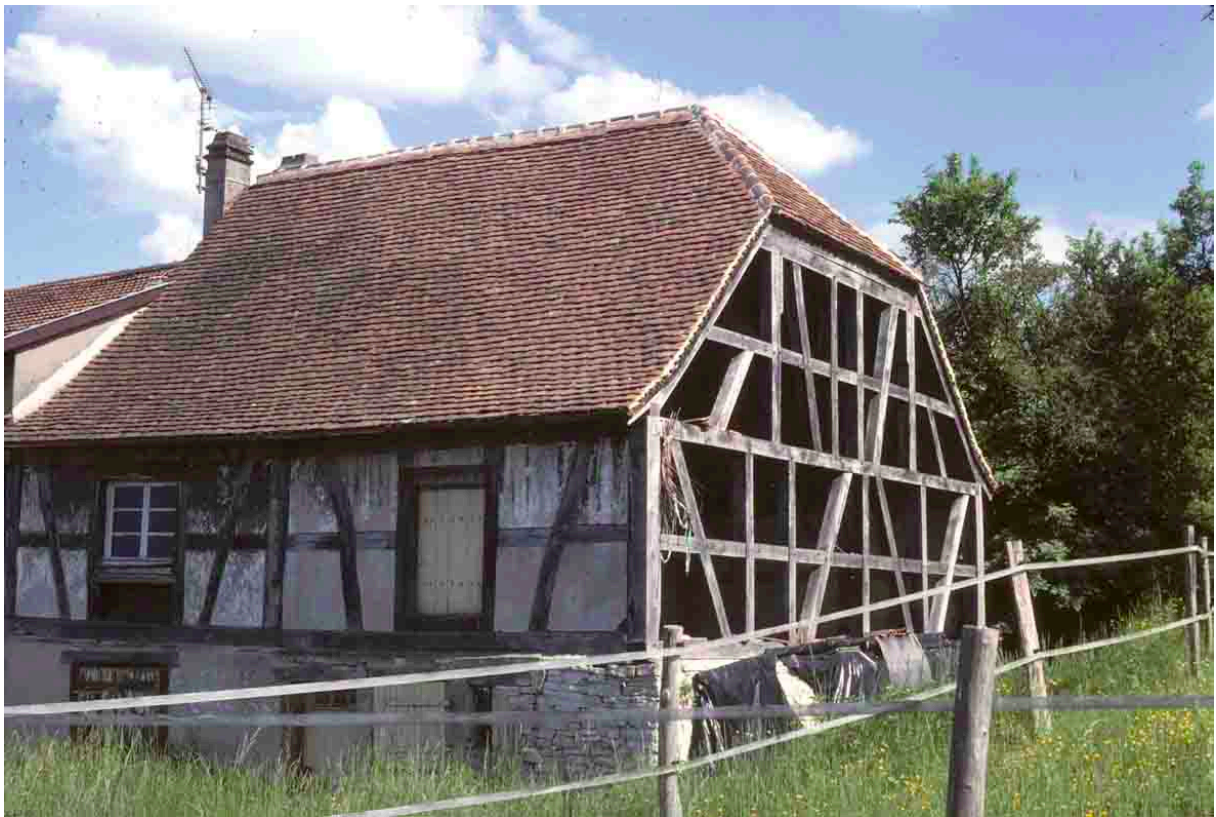
La toiture refaite, en 2002
