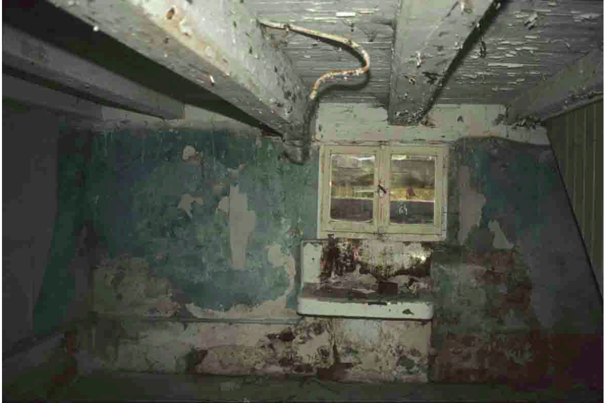
La cuisine de la maison d'Emilie, vue vers l'arrière. A gauche de la fenêtre, le linteau de la cheminée, qui forme clef entre la sablière intermédiaire arrière et la sablière intermédiaire centrale.
