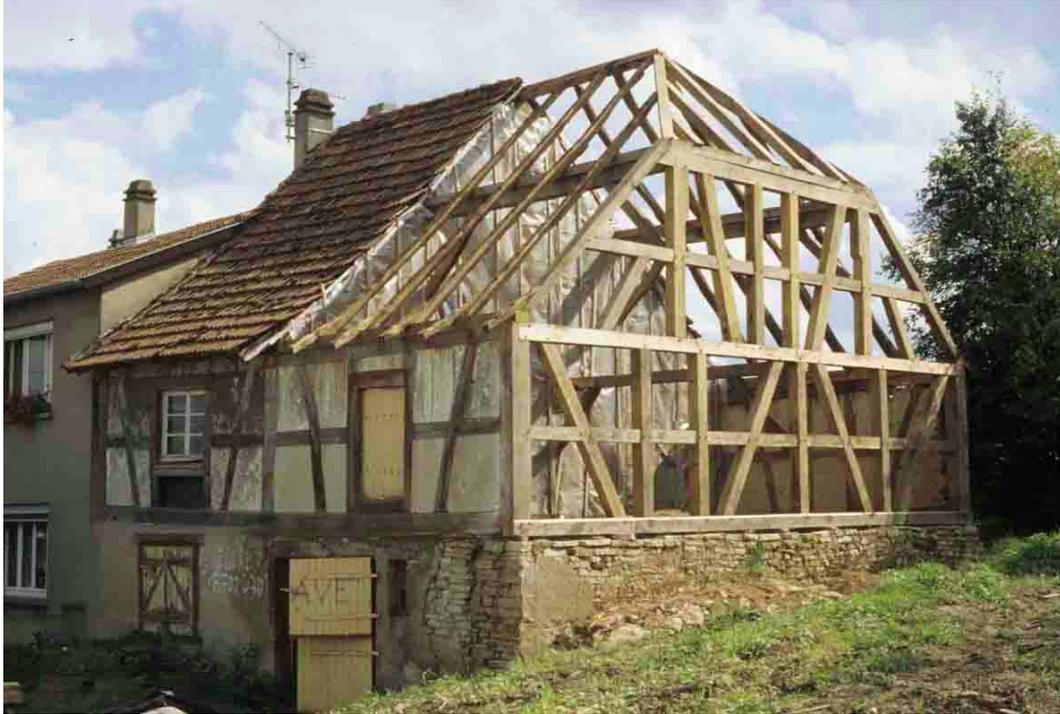
Les travaux sur la charpente et le pignon ouest ont été réalisés par l'entreprise de Jean Junker, charpentier d'Oeting, en 1995. Le dessin du pan de bois du pignon a été fidèlement repris sur celui du pan de bois intermédiaire entre le corps de logis et le corps d'exploitation. La demi-croupe du toit sert de déflecteur.
