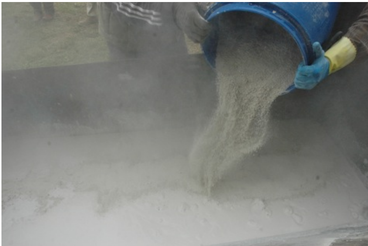
Septembre 2012, essai d'extinction de la chaux vive (Dugny), à Sailly-Achâtel.
