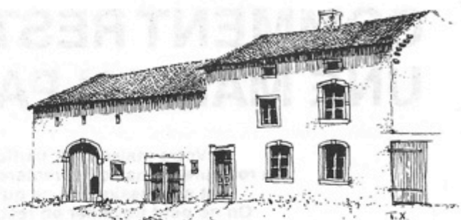
2 - Pays-Haut. Halling. Décrochement de la toiture marquant la division entre l'habitation et la partie agricole. La présence de la tuile-canal est dans le Pays-Haut plus ancienne que celle de l'ardoise.
