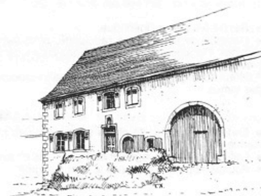
10 - Pays de Bitche. Couverture en tuiles écailles anciennes. Encadrements en grès rouge. Crépi à la chaux aérienne de teinte rougeâtre. Dans cet exemple, nombre important d'ouverture avec arcs ou segments d'arcs caractéristiques du XVIII e siècle.
