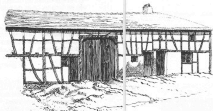
8 - Pays des Etangs. Bisping. Maison à colombage avec remplissage de torchis ou de briques. Toit à faible pente recouvert de tuiles-canal. Le bois est laissé brut. Les hourdis sont recouverts d'un enduit à la chaux aérienne.
