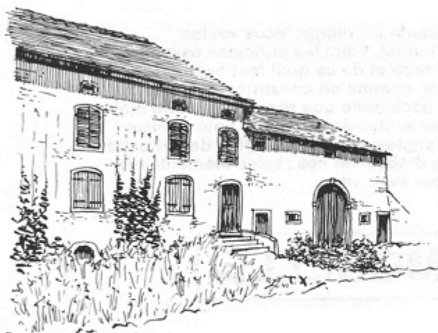
1 - Pays Haut. Basse Rentgen. Maison d'influence Luxembourgeoise. Toit d'ardoise. Décrochement entre l'habitation spacieuse et les locaux agricoles. Cave. Habitation surélevée du fait de celle-ci. Maçonnerie de grès communément appelé "pierre de sable". Il s'agit d'un matériau assez fragile aux agents atmosphériques.
