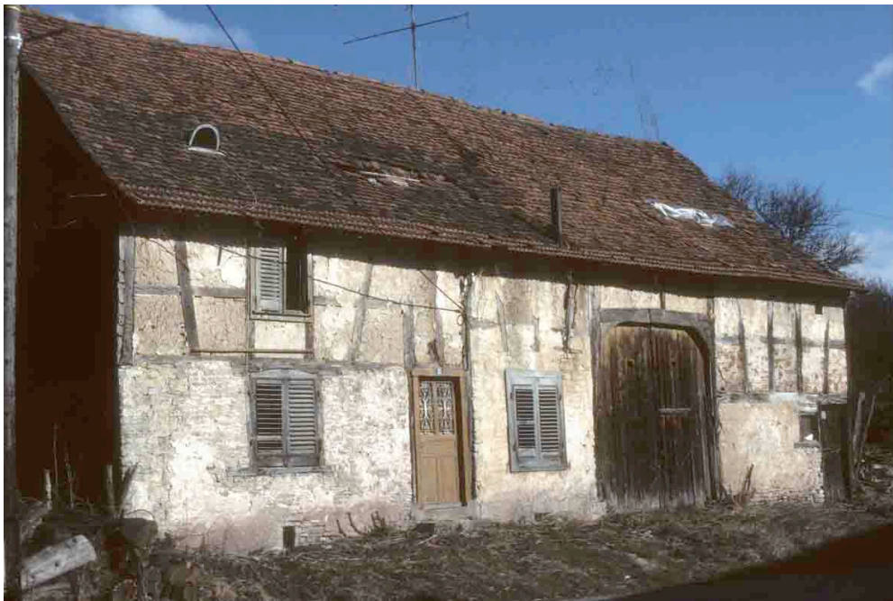
La maison, en février 1980, avant le début des travaux
