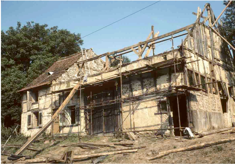
La maison, privée de sa toiture, en août 1980
