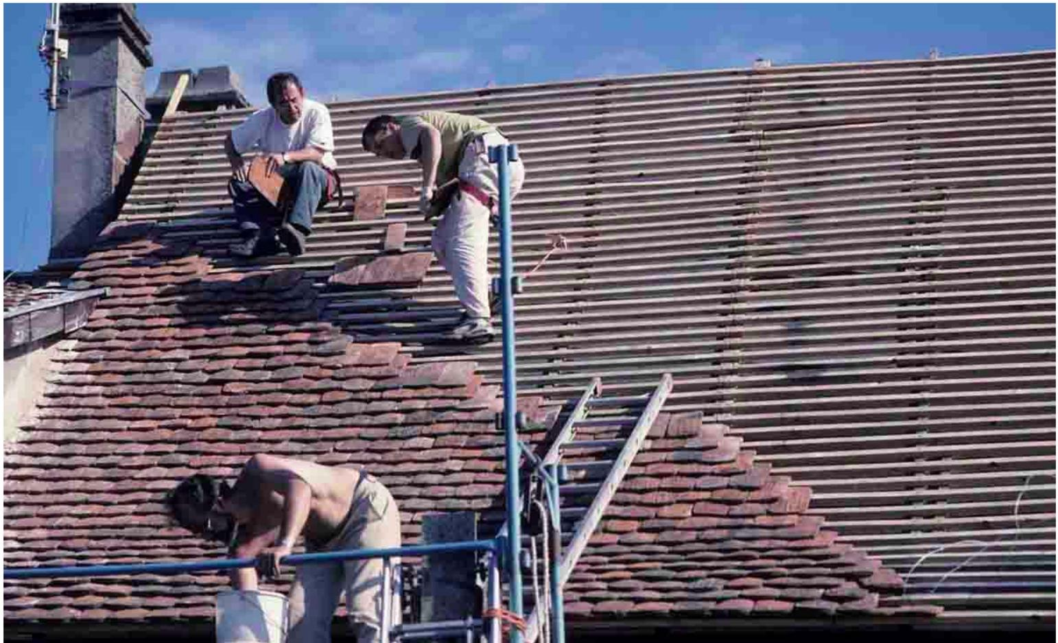
Deux procédés étaient possibles, le premier, dit en couverture simple, assurait un recouvrement par moitié, avec des joints alignés d'un rang de lui à celui qui le recouvrait, l'étanchéité étant assurée par une languette de bois glissée sous le joint longiligne. Le second, dit en couverture double, assurait un recouvrement aux deux-tiers et des joints croisés. Le premier procédé demande moins de tuiles pour un poids inférieur.
