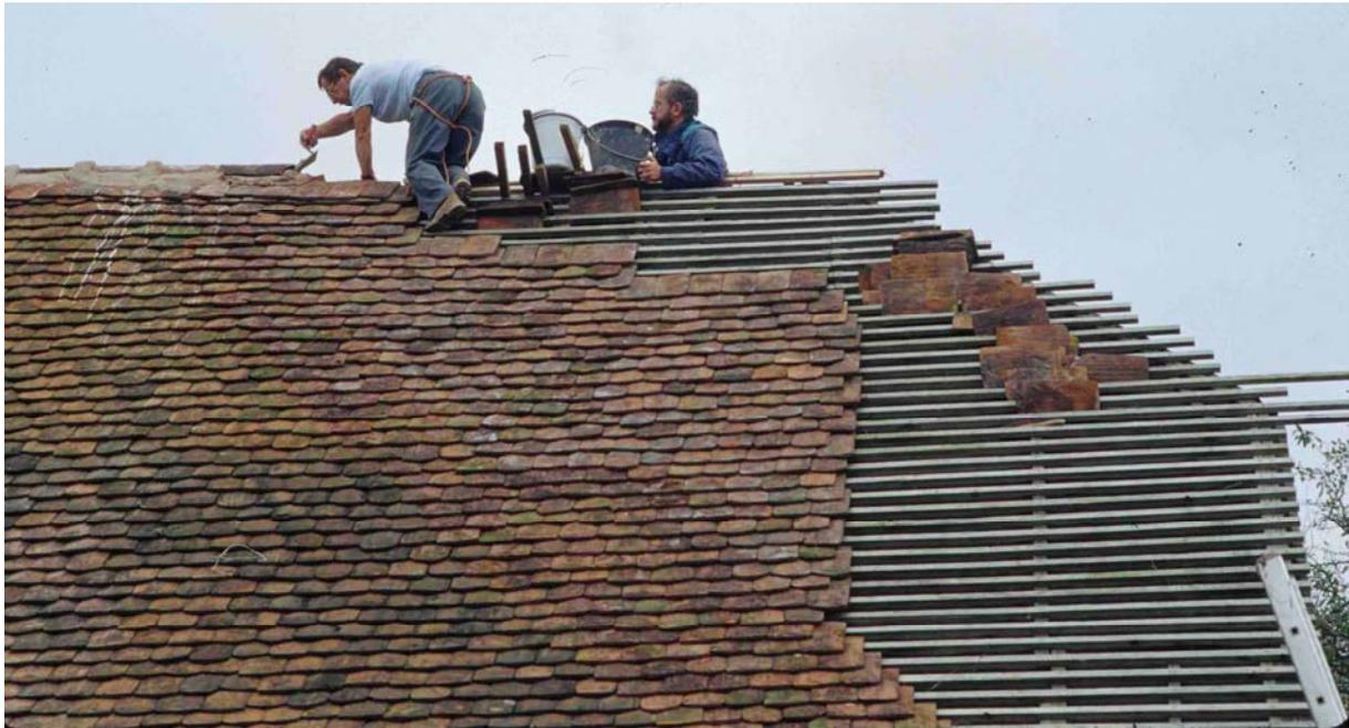
*La faîtière a été scellée au fur et à mesure de l'avancée de la couverture du long pan vers la croupe.*
