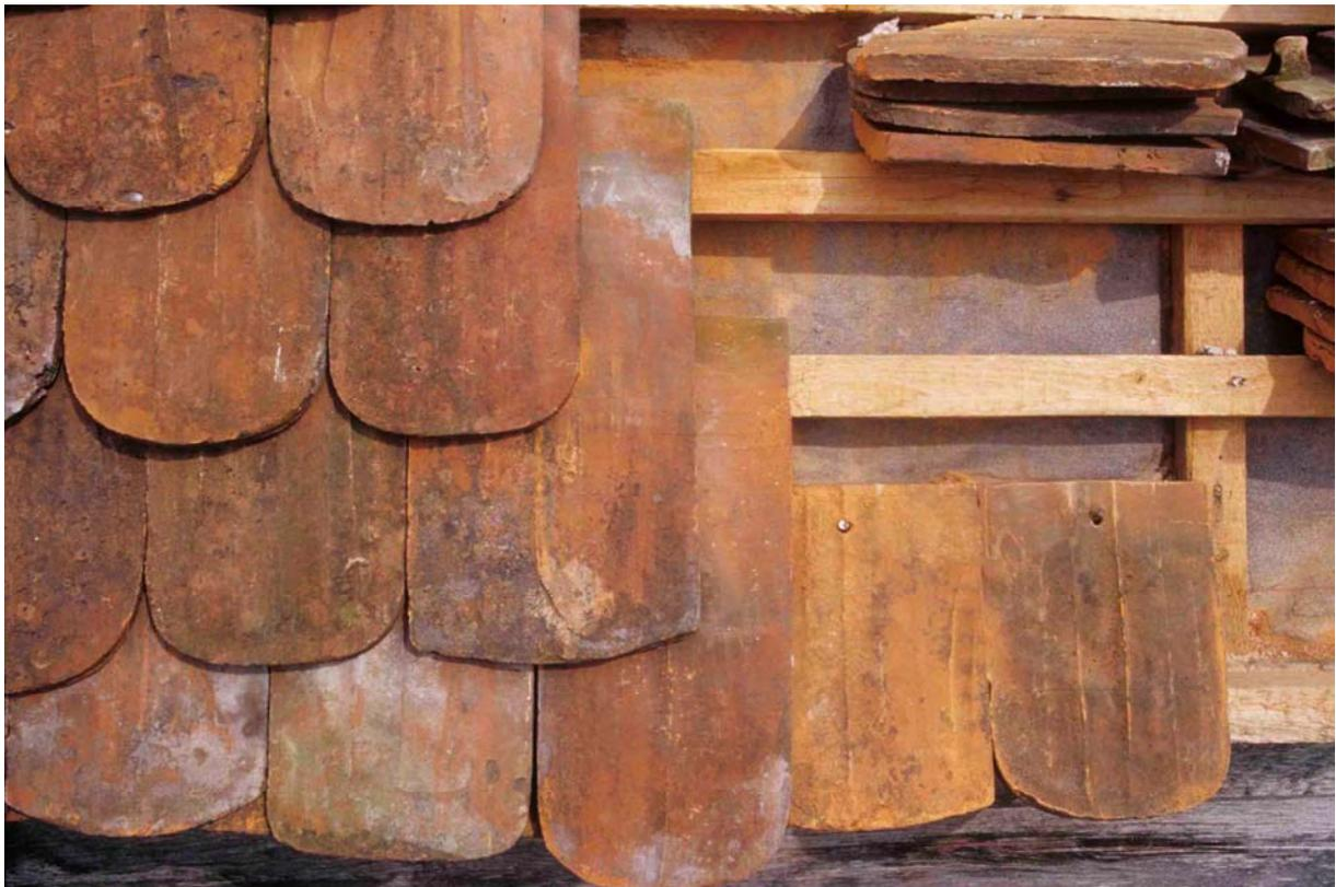
*Comme pour la façade, la mise en place de l'égout a commencé par la pose d'une demi tuile, coupée au tiers, clouée sur le voligeage et recouverte par une première tuile complète.*
