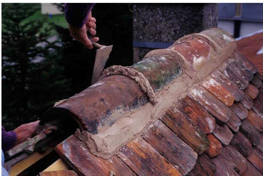
*Le mortier utilisé est un mortier de chaux hydraulique naturelle pure.*
