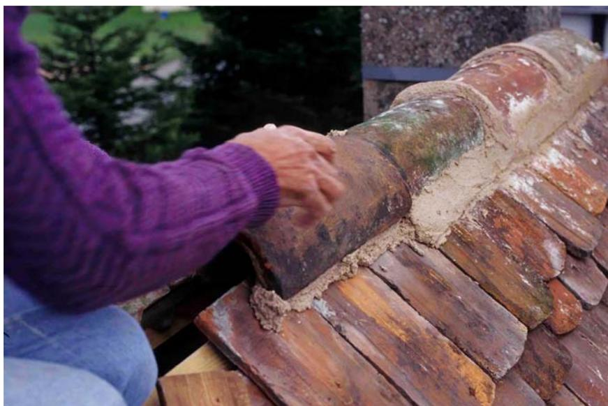
*Une première couche de mortier a été appliquée sur le haut des tuiles, sur laquelle la tuile a été scellée, avec d'être fixée par une seconde couche de mortier appliquée entre sa base et le haut des tuiles.*
