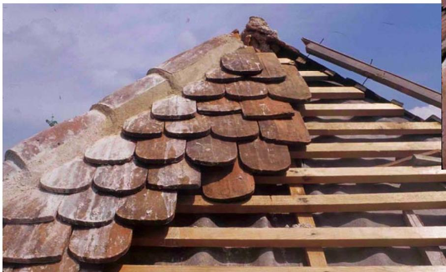
*L'arêtier à été fait de tuiles creuses tronconiques, recouvertes par celle du dessus, et maçonnées.*
