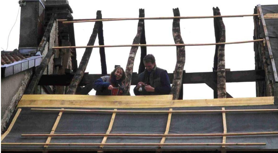
Sur les chevrons ont été posées des voliges, recouvertes d'un carton goudronné assurant une sous couverture étanche. Des contre-lattes ont été clouées le long des chevrons, de manière à créer un joint d'aération entre cette sous couverture et les tuiles
