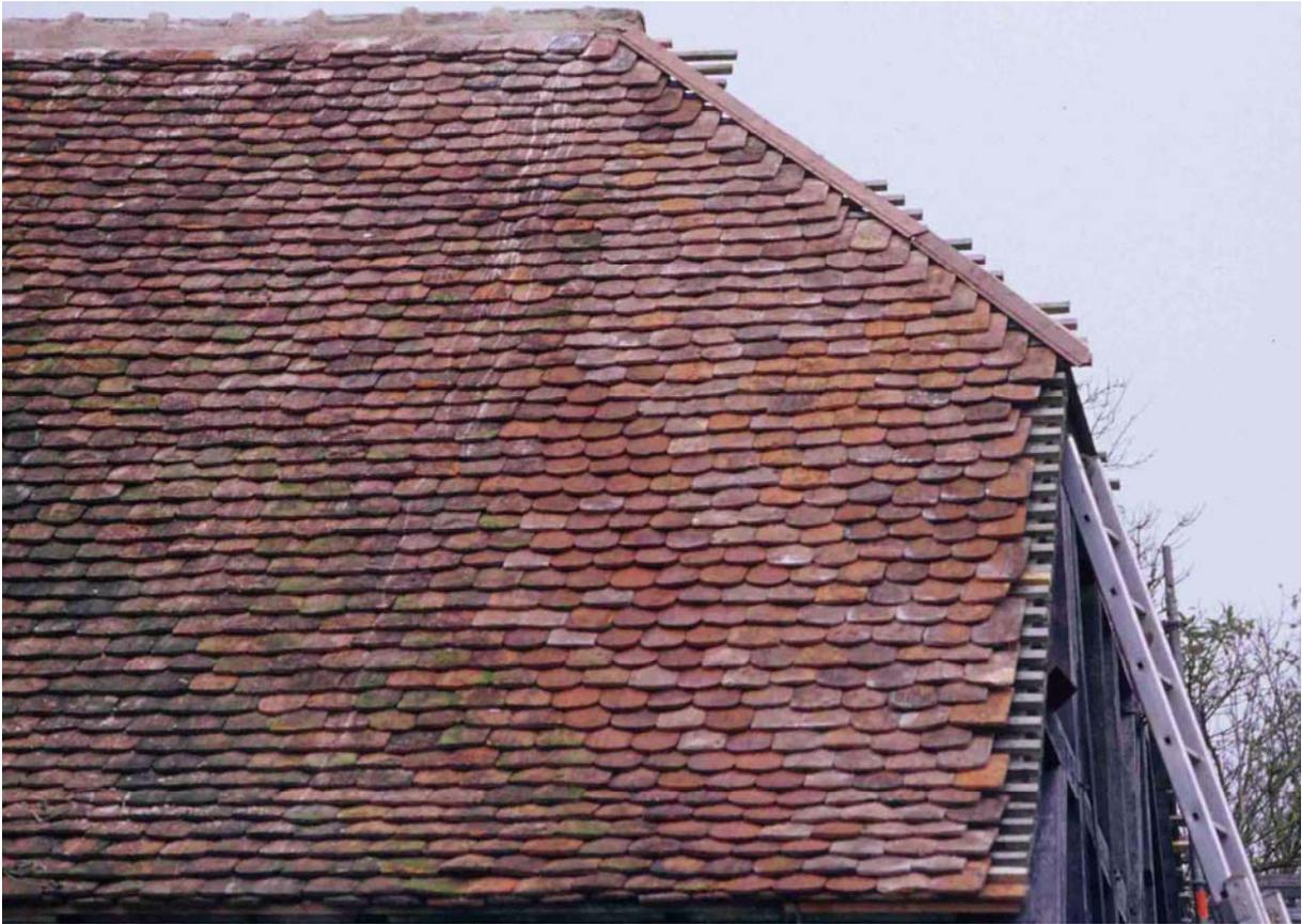
*En rive, il fallait scier une tuile sur deux dans le sens de la longueur.*
