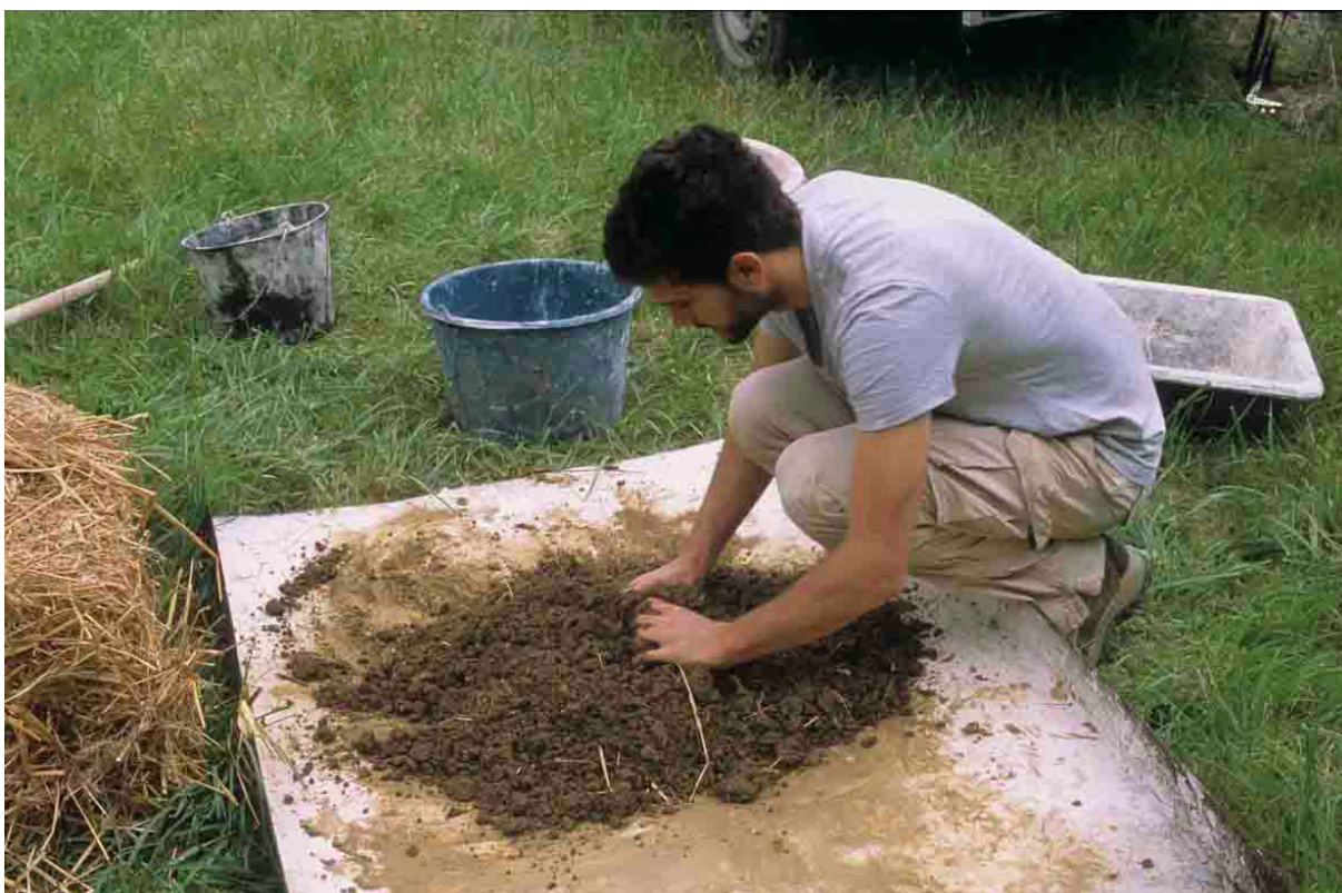
Le torchis utilisé provenait d'un reliquat de celui de 2004. La paille avait disparu, il fallait donc la rajouter.
