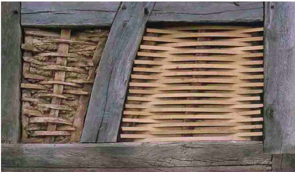
À gauche, le clayonnage d'origine, avec ce qu'il restait de torchis sur la face intérieure.
