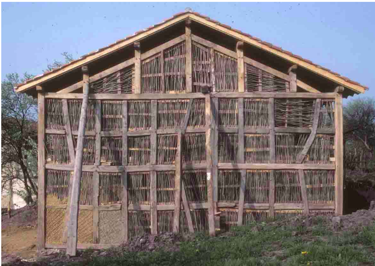
Les étrésillons ont été pris dans du bois de palette, le clayonnage a été coupé sur du saule.
