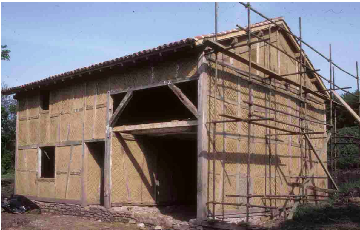
Il reste à terminer le pignon.
