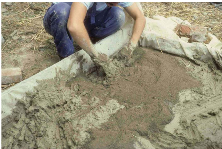
Le mélange avec la paille, dans une cuve de polyane.
