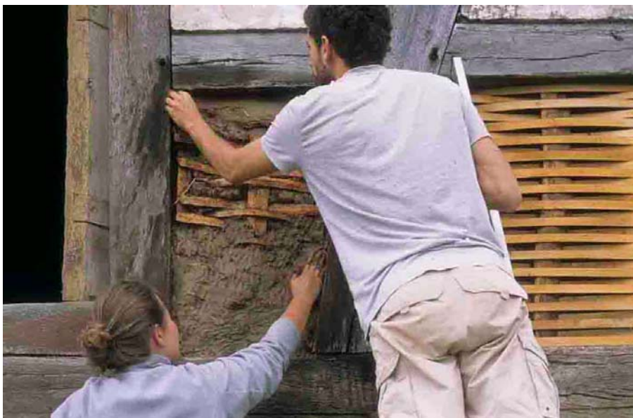
Le torchis a été appliqué, aussi profondément que possible, dans le clayonnage.
